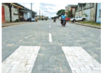
Reabertura Rua Algarve
